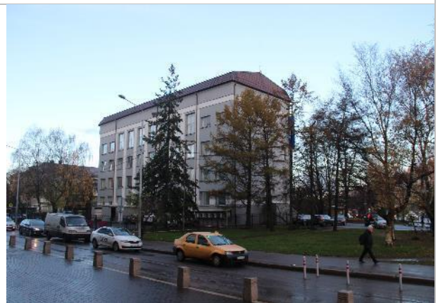
Фото 12. Внешнее состояние объекта.
