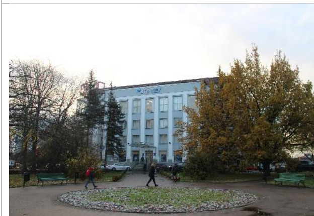
Фото 5. Внешнее состояние объекта.
