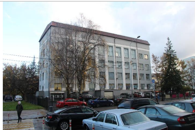
Фотография 3.1. Внешнее состояние объекта
