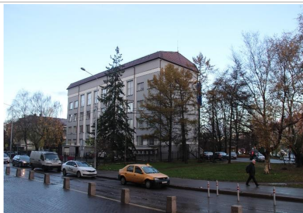
Фотография 3.2. Внешнее состояние объекта
