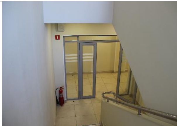
Фото 21. Внутренние помещения объекта.
