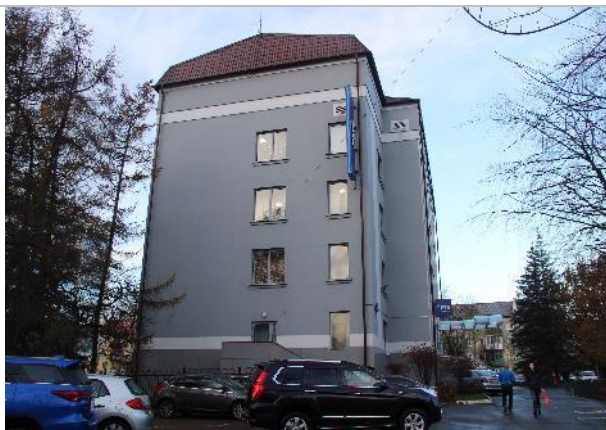
Фото 14. Внешнее состояние объекта.
