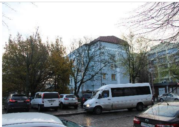
Фото 6. Внешнее состояние объекта.
