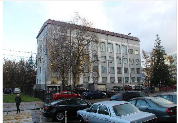
Фото 8. Внешнее состояние объекта.
