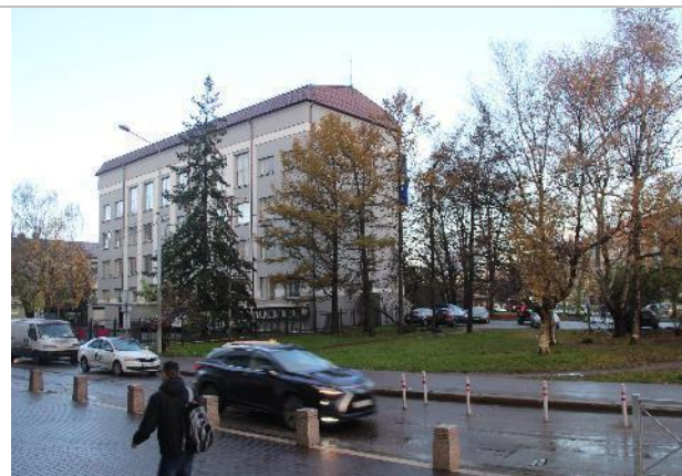
Фото 13. Внешнее состояние объекта.
