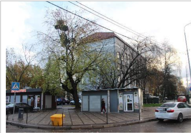
Фото 7. Внешнее состояние объекта.
