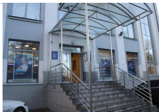
Фото 15. Внешнее состояние объекта.
