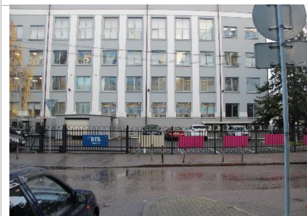
Фото 9. Внешнее состояние объекта.
